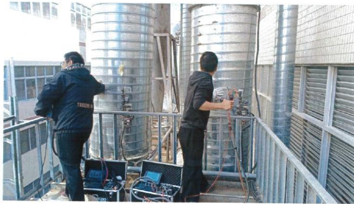
木加工工序 3#、4#废气处理前采样口 (3#左、4#右)
