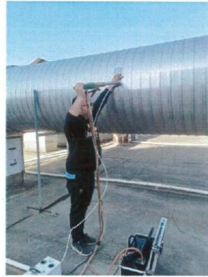
喷漆工序 11#废气处理前采样口
