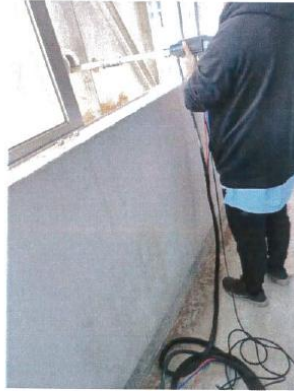
木加工工序 3#废气处理后排放口
