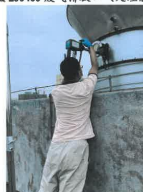
FQ-290440 废气排放口（处理后）
