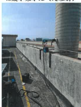
FQ-290439 废气排放口（处理后）
