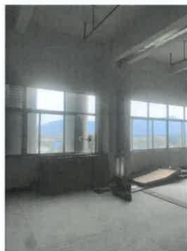
FQ-290440 废气排放口（处理前）
