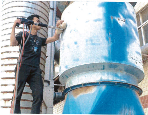
木加工工序 1#废气处理后排放口
