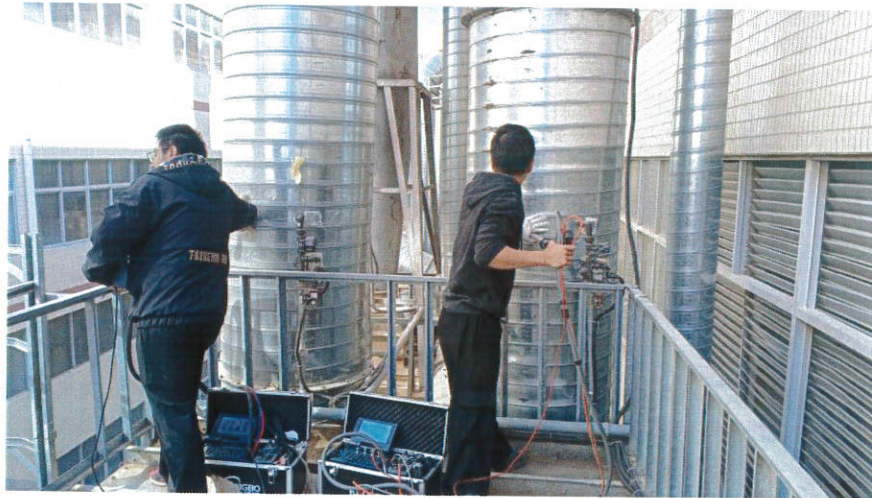
木加工工序 3#、4#废气处理前采样口 (3#左、4#右)
