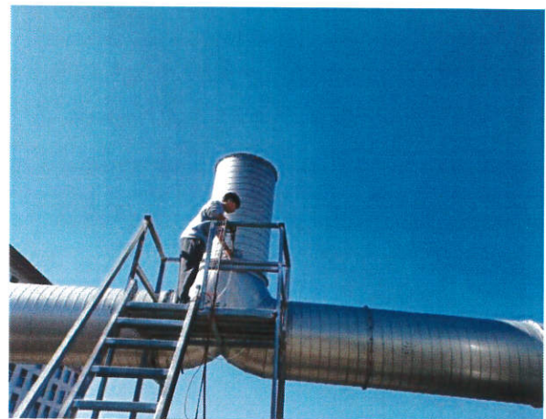
喷漆工序 4#废气处理后排放口
