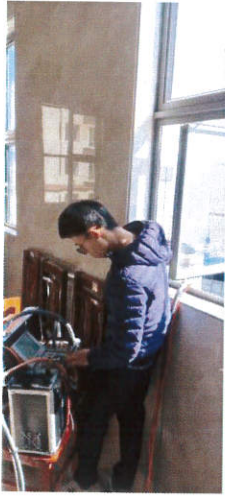
厨房油烟废气处理后排放口
