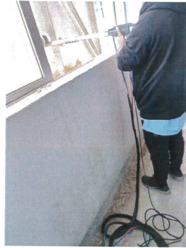
木加工工序 3#废气处理后排放口
