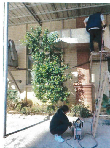
厨房油烟废气处理前采样口
