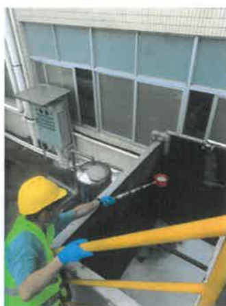
1#废水集水池（处理后）
