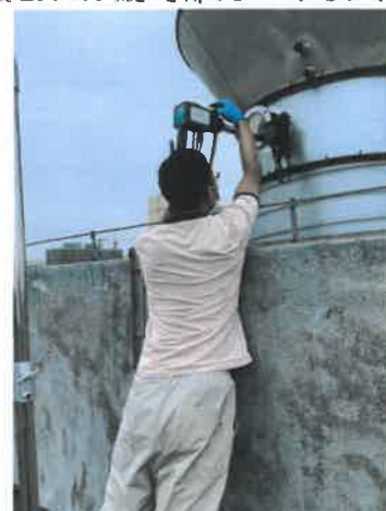
FQ-290440 废气排放口（处理后）
