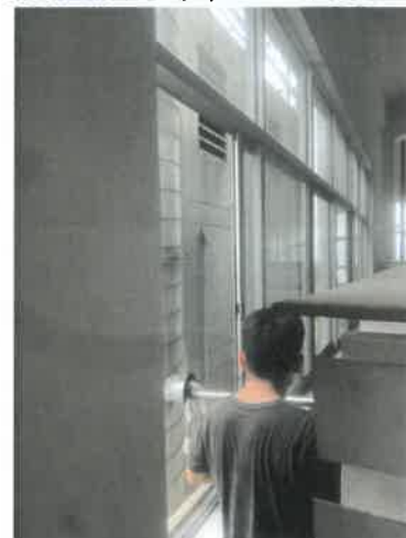
FQ-290442 废气排放口（处理前）
