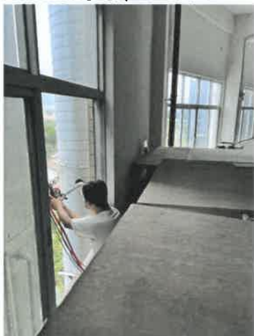
FQ-290441 废气排放口（处理前）
