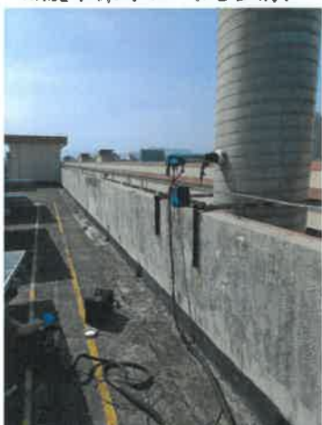
FQ-290439 废气排放口（处理后）
